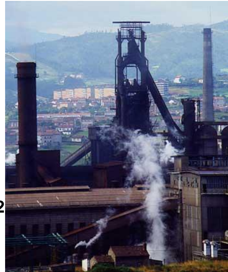
ДОМЕННАЯ ПЕЧЬ В Авилесе (Испания).
